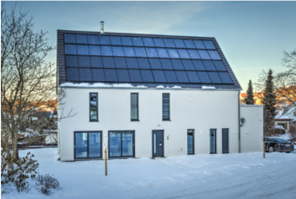
Abbildung 6-24: Messtechnisch untersuchtes Gebäude in Döhlau (DOE) Quelle: Gemeinhardt AG
