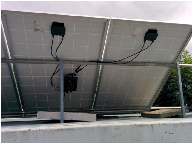
Abbildung A. 10: Modul-Wechselrichter installiert (links) und Bauteil des Herstellers ABB (rechts)
