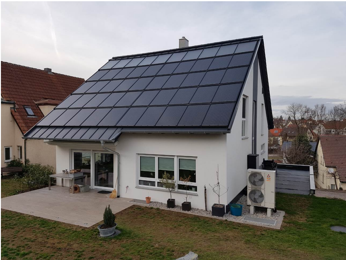
Abbildung 6-33: Messtechnisch untersuchtes Gebäude in Heilbronn-Neckergartach (HNN) Quelle: Marco Jens, KHB-Creativ Wohnbau GmbH
