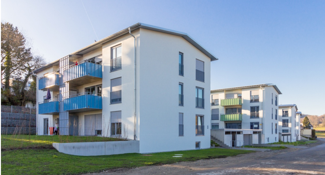
Abbildung 6-2: MFH KON – Gebäudeansicht der vier Mehrfamilienhäuser [Quelle WOBAK]
