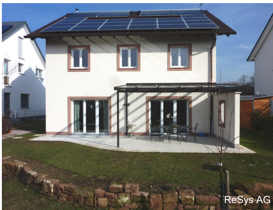
Abbildung 6-52: Ansicht des Gebäudes aus der südlichen Richtung
