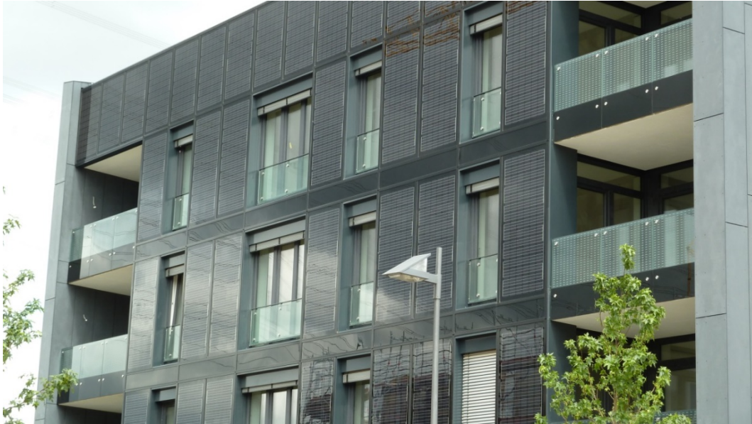
Abbildung 6-13: MFH FFM Gebäudeansicht [Quelle EGS Plan]
